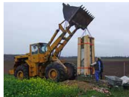
Der Radlader im Einsatz
