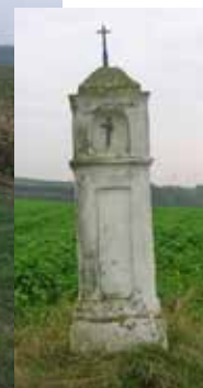
Das Marterl vor und nach der Renovierung
